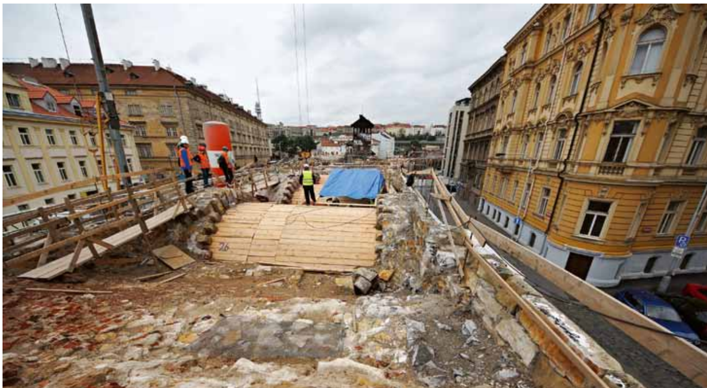
Přezdívání nevyhovujících kleneb na podpůrné skruži
